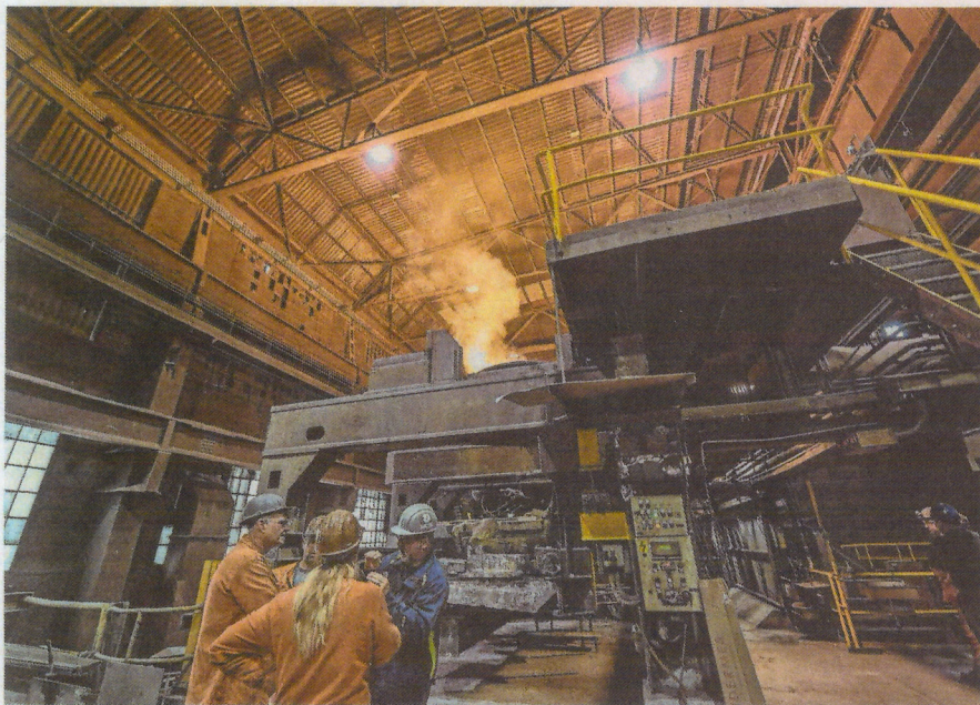
Wochenlang waren die Mitarbeiter des Stahlwerks dabei, alles für den neuen Schmelzofen vorzubereiten.
